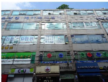
写真 参 3-1 高齢者施設雑居ビル(2～5階、各階に異なる高齢者施設が入居)
