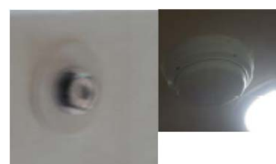
写真参 1-14 左:SPヘッド、右:熱感知器
