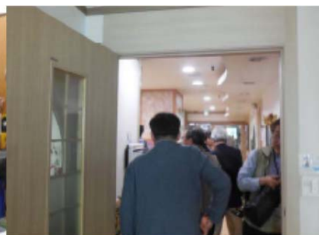
写真 参 3-6 廊下部の扉（ガラスが入っており、見通しが利く）
