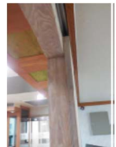
写真16 吊り扉の仕様
