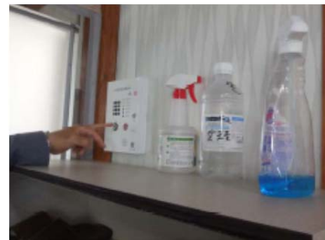
写真参 1-12 扉の開錠 (2階で制御)
