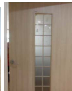
写真15 ガラスを配置した扉
