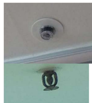
写真 24 SP ヘッド(上:ヒュージブルリンク型、下:ガラスバルブ型)
