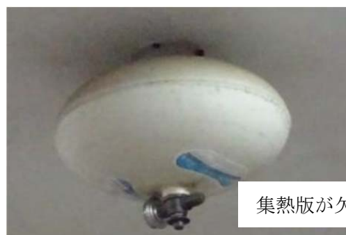
写真 27 天井据え付け消火設備 (住宅用下方放出型自動消火装置)
