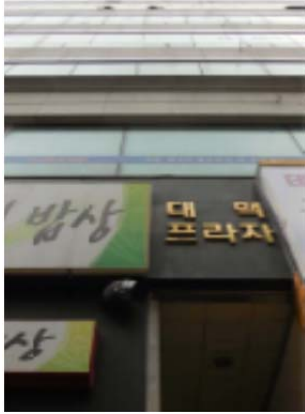
写真参 2-1 施設外観 (雑居ビルの2階)
