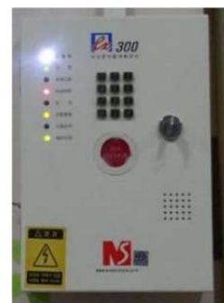
写真 22 自動通報装置
