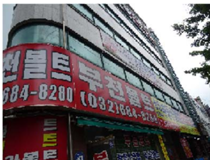
写真参1-1 ソオン養老院外観 (雑居ビルの2～6階)
