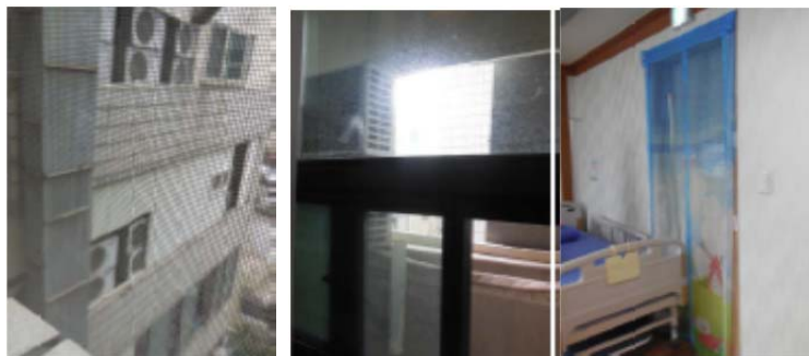
写真 18 バルコニーの状況（右：狭いバルコニーに空調機の屋外機設置状況、中央：室内から見た状況、左：バルコニー出口の扉：室内からはわかり難い。）
